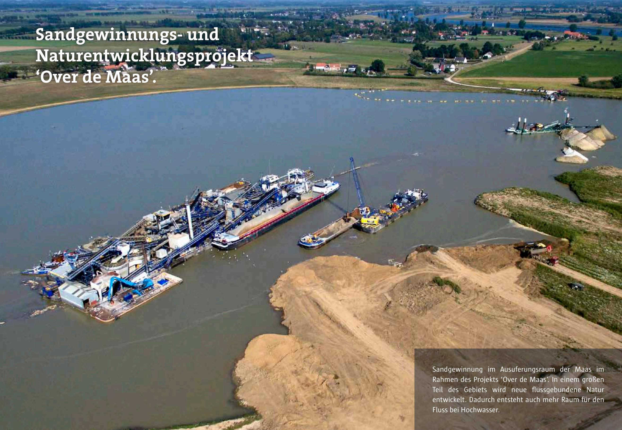
Sandgewinnung im Ausuferungsraum der Maas im Rahmen des Projekts 'Over de Maas'. In einem großen Teil des Gebiets wird neue flussgebundene Natur entwickelt. Dadurch entsteht auch mehr Raum für den Fluss bei Hochwasser.
